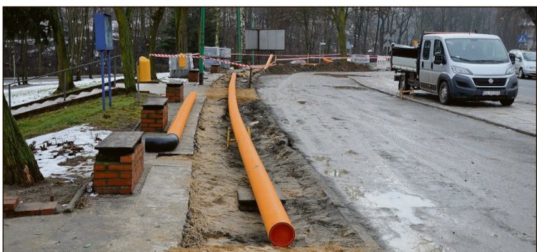
W ramach budowy sieci gazowej przy ul. Krótkiej i Legnickiej ułożony zostanie gazociąg o długości ok. 410 m
