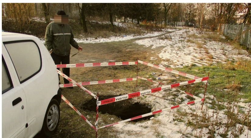
Do takiej dziury wpadł pies, który na szczęście szybko trafił do rąk właściciela (na zdjęciu)
