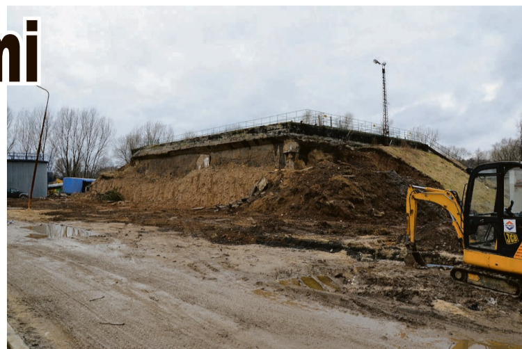
Z osadnika Imhoffa stopniowo usuwana jest skarpa ziemi
