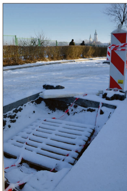
Nowa ul. Wojska Polskiego będzie miała podbudowę głęboką na 0,5 m. Na zdjęciu – studzienka w pobliżu ul. Hożej. Na tym odcinku wylano już warstwę nośną asfaltu
