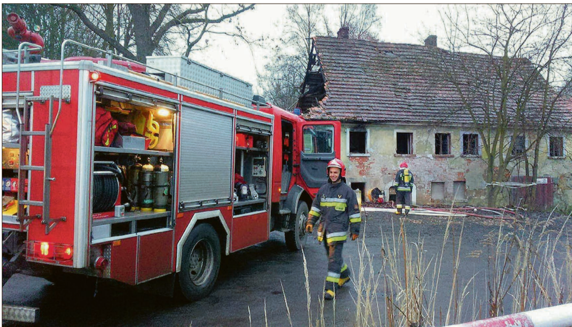
Budynek, w którym doszło już dwukrotnie w ostatnich miesiącach do pożaru/fot. arch. KP PSP Złotoryja
