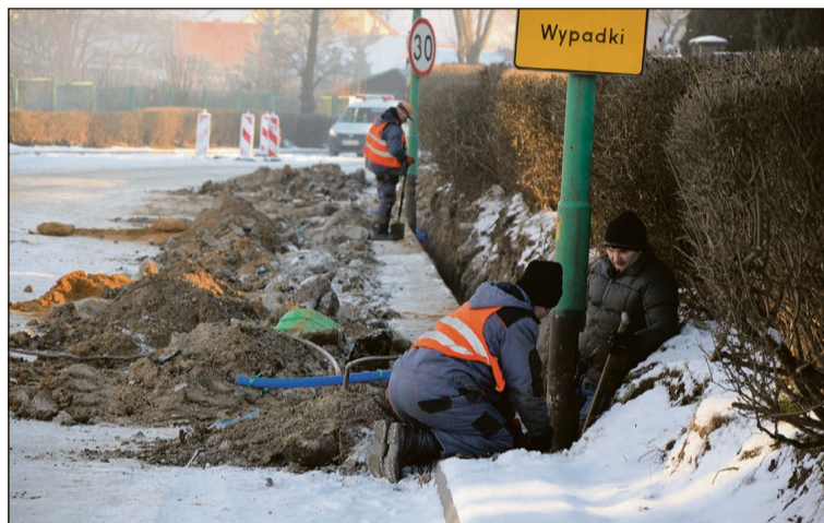
W tym tygodniu ekipy RPK naprawiały uszkodzony podczas robót drogowych przewód do latarni ulicznych
